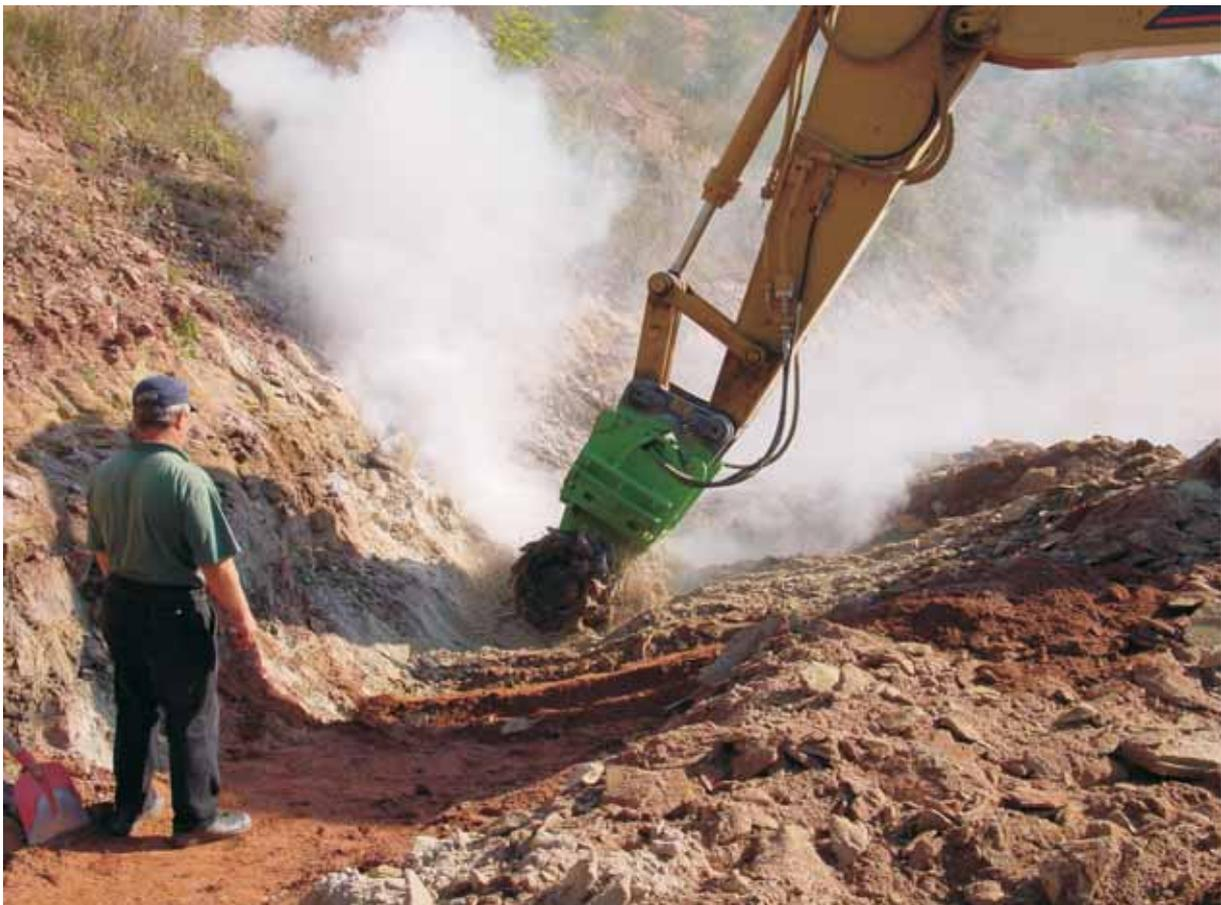
Baggeranbaufräse beim Abfräsen von Beton (Cat 325 C LN)
