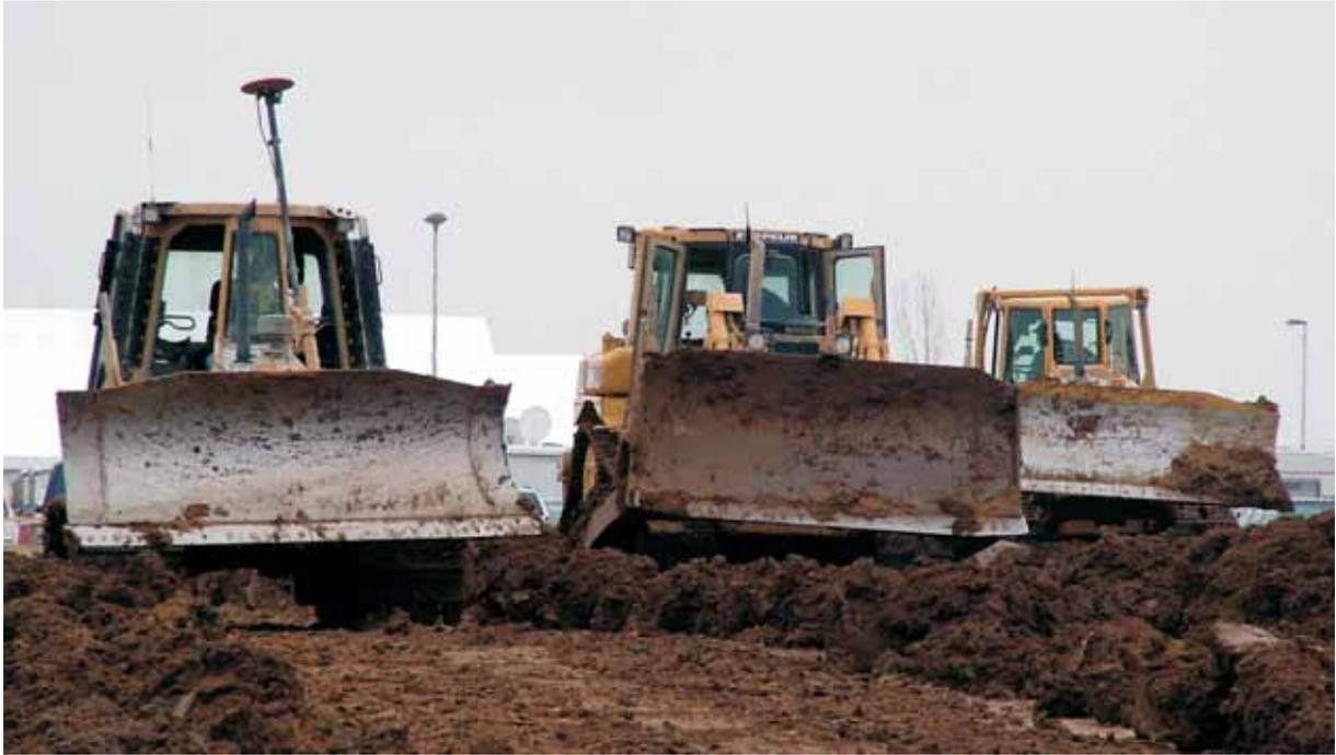
Zwei Caterpillar D6 und eine D5 beim Abschieben von Mutterboden
