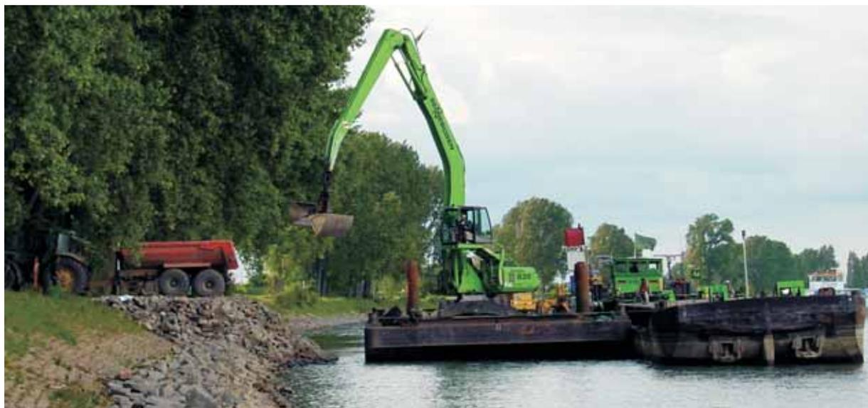
Entladung des Leichters "Otto" vom Ponton "S6" aus mittels Sennebogen 835 (~35 to.). Beladung der Transportfahrzeuge auf der Rampe vom Wasser aus.
